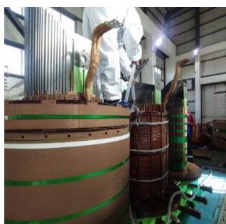
Буянт-ухаа дэд станцын трансформаторын засвар
