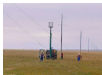
Газрын тос дамжуулах хоолойн өргөх халаах станц-2-ын 110 кВ-ын ЦДАШ-ын барилга угсралтын ажил
